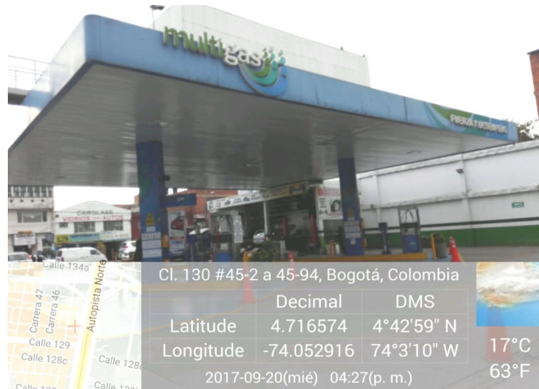
Fotografía No 2. Aviso en fachada (canopy) ubicado en el costado noroccidental del predio.
