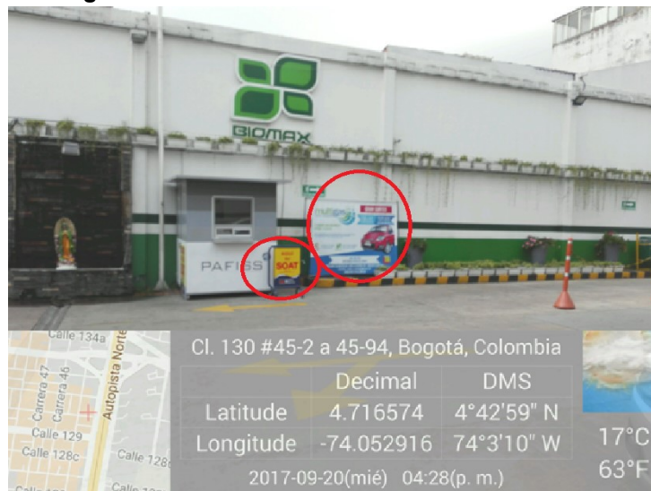
Fotografía No 5. Elementos no autorizados ubicados al costado norte occidental del predio
